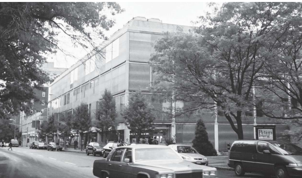
北西側外観 1階は店舗 外壁ステンレス生板 柱梁コンクリート
