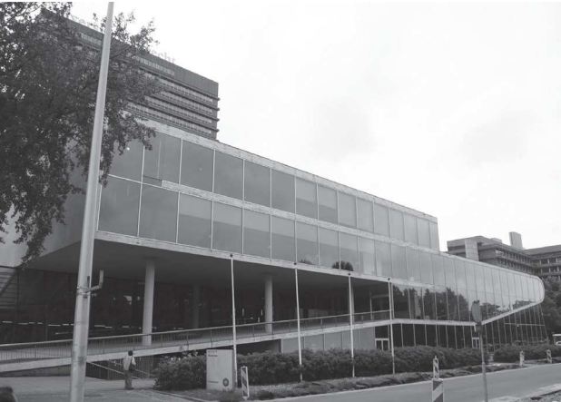
北側外観 1階右側カフェテリア、2階大講義室 3、4階試験ホール
